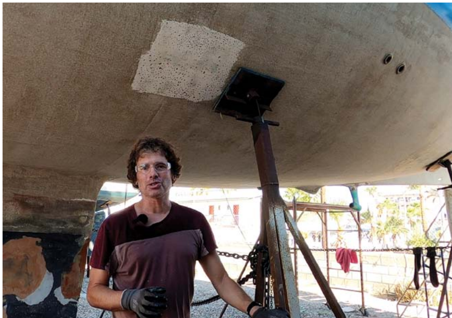
Właśnie kończę usuwanie żelkotu.
