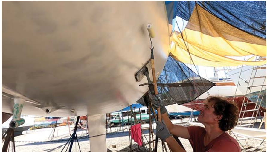
Druga warstwa bariery epoksydowej.
